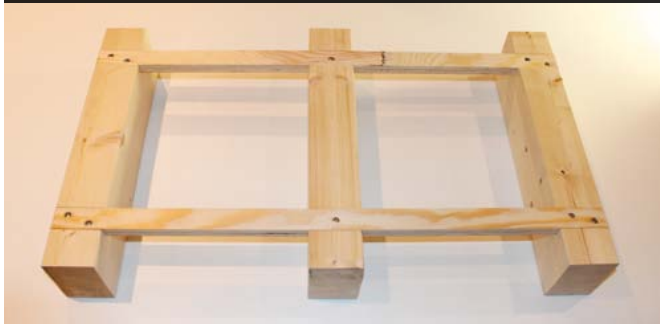
Figur 1: SPÆR OPLÆGGES
