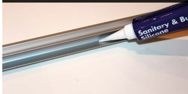
Figur 6: SILIKONE PÅFØRES VANDNÆSEPROFIL
