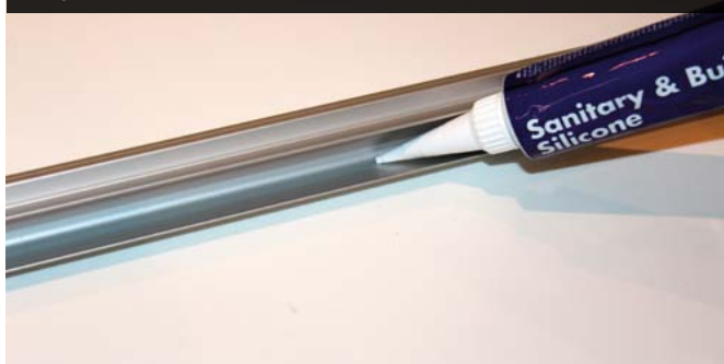
Figur 8: SILIKONE PÅFØRES VANDNÆSEPROFIL
